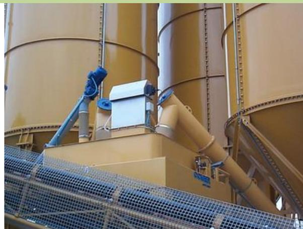
Бункер, заполняемый шнековым питателем или самотеком
